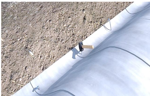
Рис. 4 – Закріплення полотна у пази металевими анкерами
