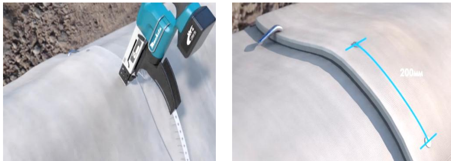
Рис. 5 – Кріплення (фіксація) бетонних полотен між собою
