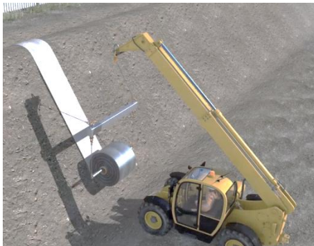
Рис. 2 – Розгортання бетонного полотна
